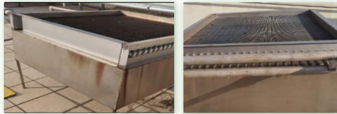
华鹏收缩炉蒸汽排放回收和蒸汽冷凝水热量回收设备
